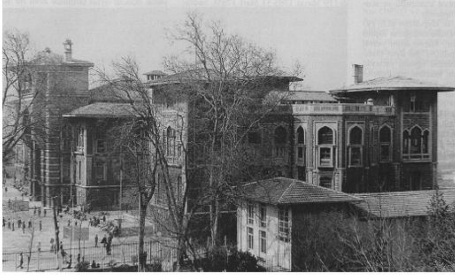
Düyun-ı Umumiye İdaresi binasının güneydoğu cephesinden görünümü
